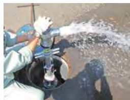
洗管(ラクエア+スタンドパイプ)
