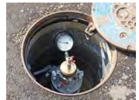
水圧測定(ラクエア+圧力計)
